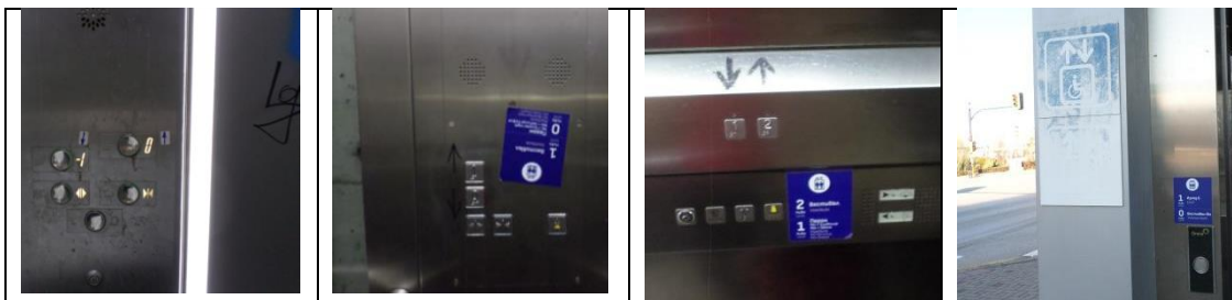
Фиг. 4. Скъпите, красиви и общодостъпни асансьори при метростанции и подземи в София. Постоянно вандализирани, въпреки постепенното подобрене на визуалната комуникация. Без импровизираните стрелки и въпреки наскоро добавените стикери, макар да имат брайлово обозначение, звукова и светлинна сигнализация, не са достатъчно ясни и разбираеми за повечето местни хора в динамичната среда на метростанциите.
